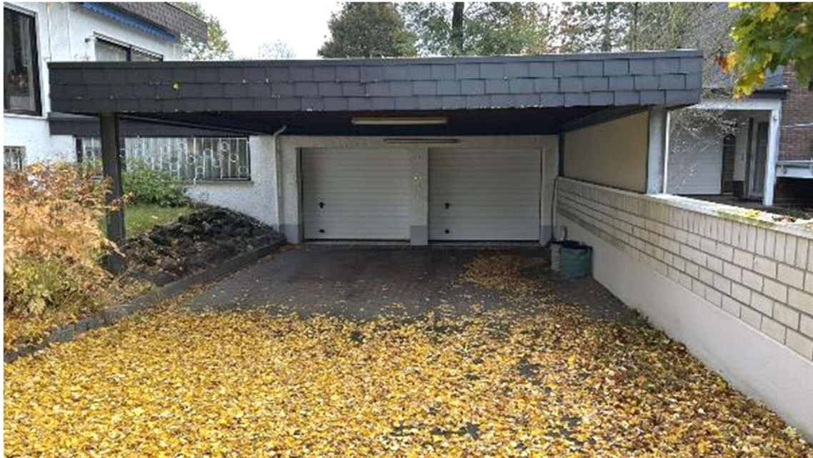
Bild B6 Doppelgarage
