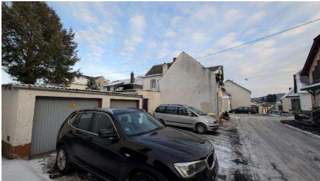
Bild B10 exemplarische Ansicht Garage
