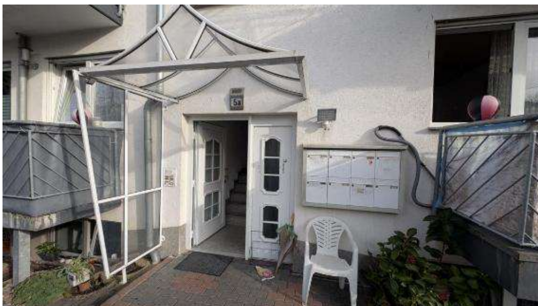
Bild B11 Eingangsbereich Mehrfamilienhaus
