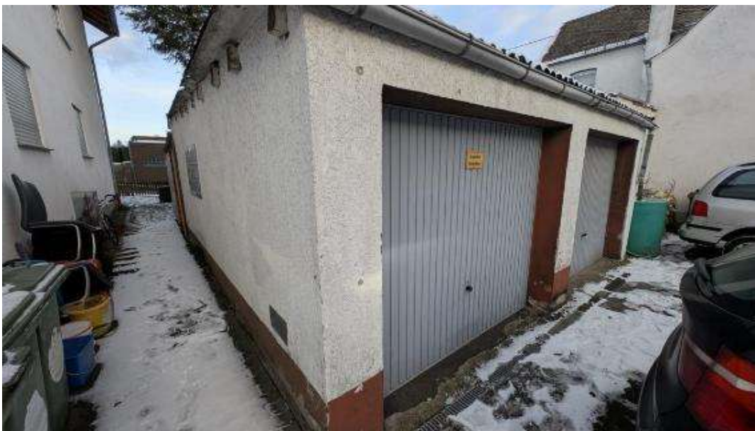
Bild B9 exemplarische Ansicht Garage
