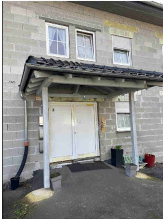
Bild B5: Hauseingang
