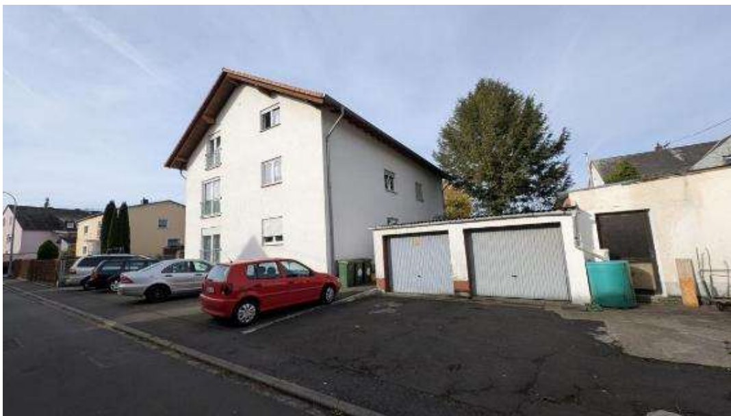
Bild B3 exemplarische Ansicht Mehrfamilienhaus
