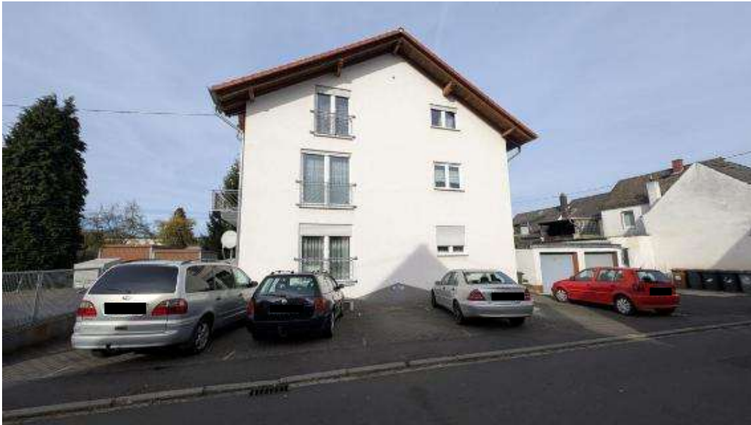
Bild B2 exemplarische Ansicht Mehrfamilienhaus
