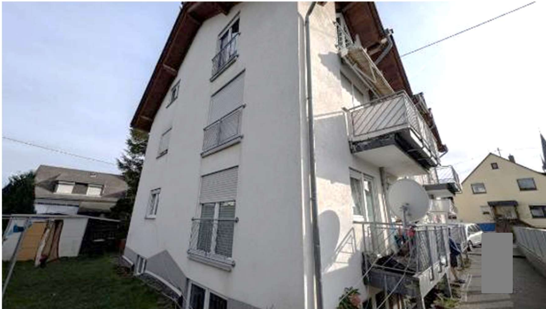
Bild B4 exemplarische Ansicht Mehrfamilienhaus
