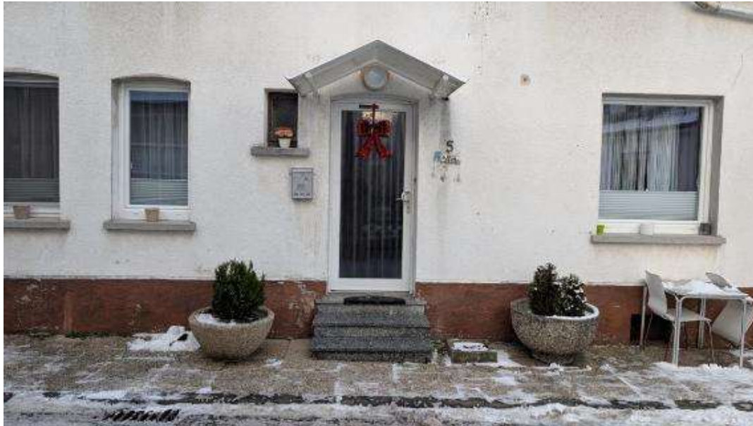
Bild B12 Eingangsbereich Wohnhaus
