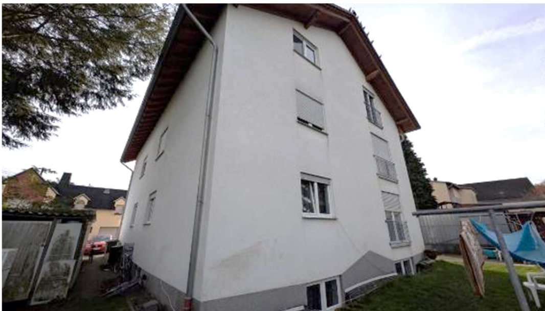
Bild B5 exemplarische Ansicht Mehrfamilienhaus
