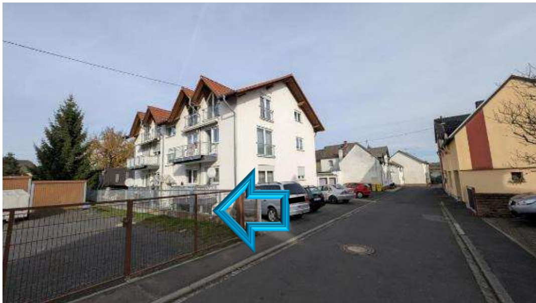
Bild B1 exemplarische Ansicht Mehrfamilienhaus
