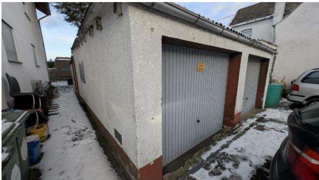
Bild B9 exemplarische Ansicht Garage
