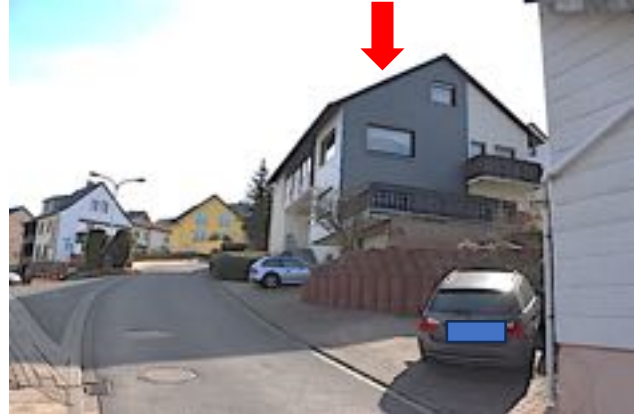
Straßenverlauf „Hahnengasse“ mit dem Objekt
