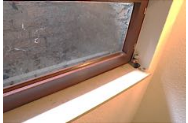
Detail Fenster im Treppenhaus
