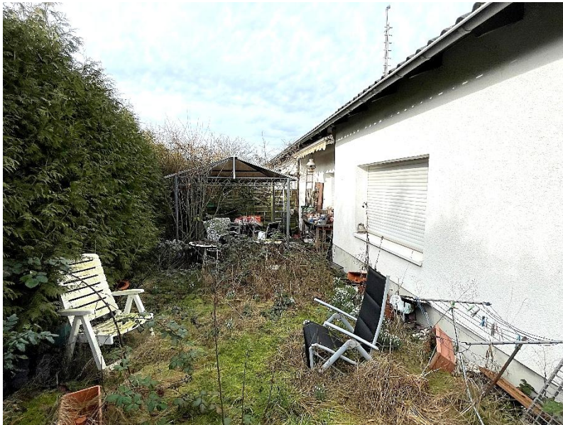
Bild 3: Terrasse und rückseitige Ansicht des Wohnhauses
