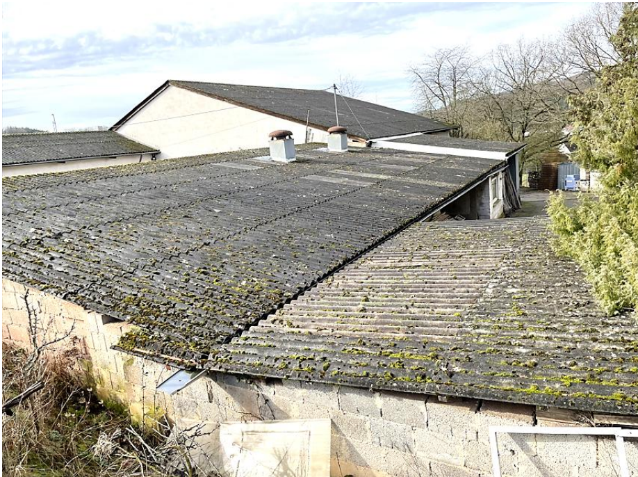
Bild 7: Geräteschuppen mit Anbauten von Osten
