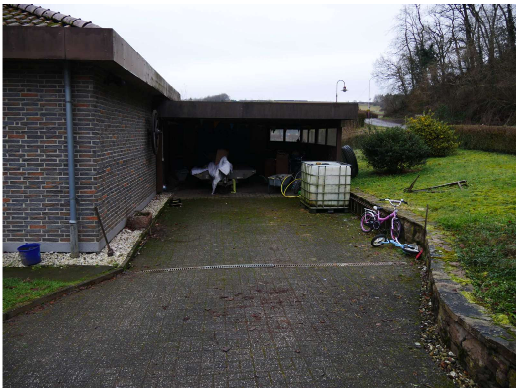
Bild 4: Vorderansicht Carport und Garage
