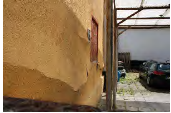
Bild 16 Putzschaden
