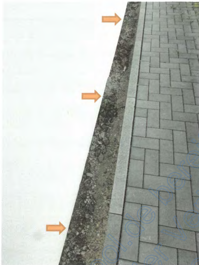
Foto 11: Wohnhaus, fehlende Bekiesung/Befüllung der Traufkante
