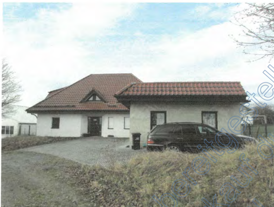
Foto 5: Wohnhaus und PKW-Doppelgarage, Straßen-/Seitenansicht
