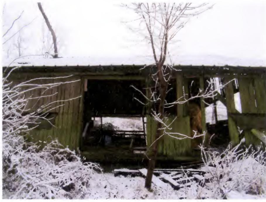
Foto 4: Fäulnis an den Stützen. Die Standsicherheit der Feldscheune wird als nicht mehr gegeben angesehen. Das Gebäude ist abbruchreif und nicht mehr wertrelevant.
