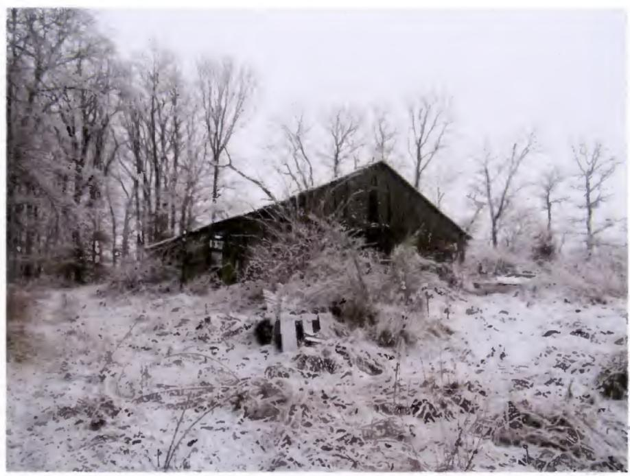
Foto 3: Die seitliche Brettverschalung fehlt teilweise, bzw. ist stark verwittert. Das Dach ist mit Zinkblech eingedeckt.
