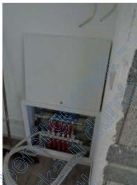
Bild 46: DG Wohnung 5 (rechts), Verteiler Fußbodenheizung
