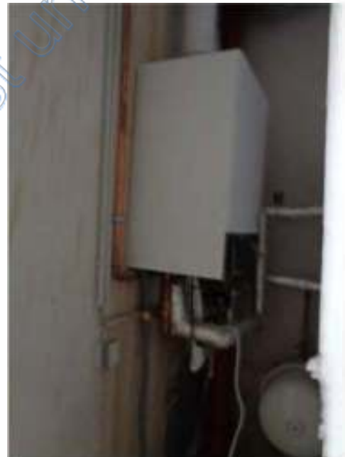
Bild 52: EG Heizraum, Gastherme
