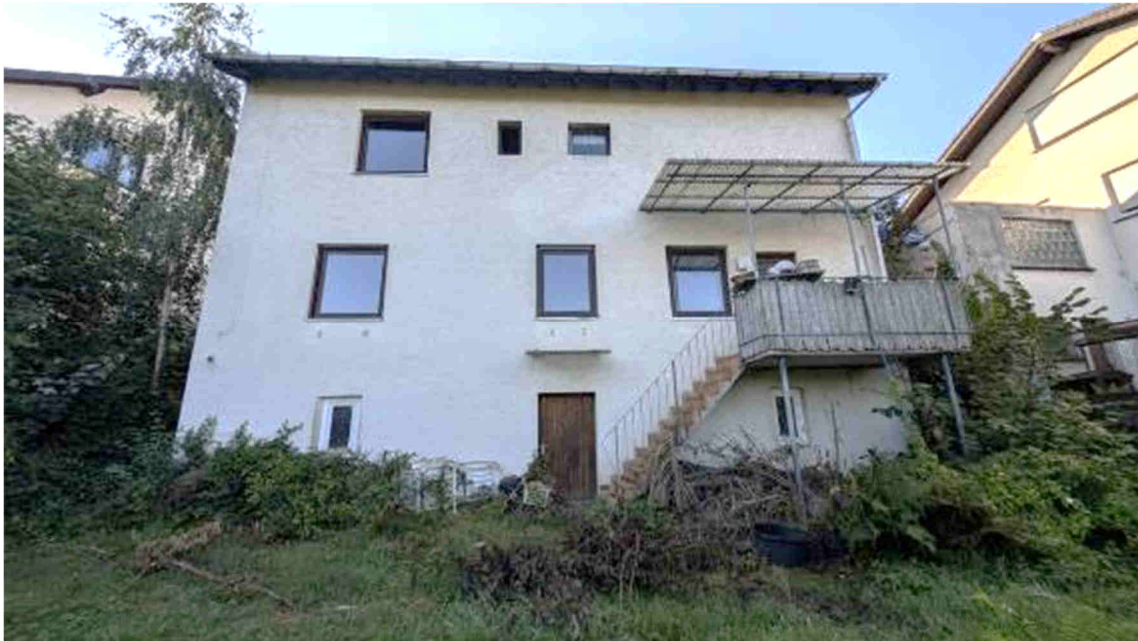
Bild B3 Gebäuderückseite
