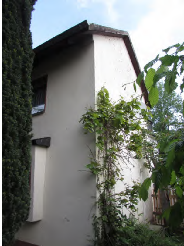
Foto 9: Wohnhaus, südöstliche Giebelwand
