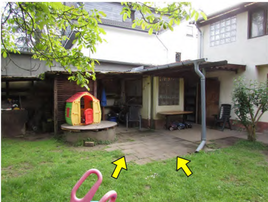
Foto 12: Abstellraum-Anbau mit rückwärtig angeschleppten Überdachungen, abgesetzte Betonplattenbefestigung
