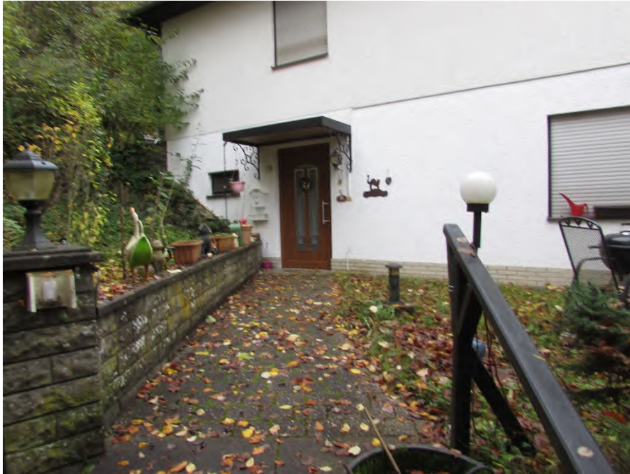
Foto 23: Zugang zum Sockel-/Untergeschoss
