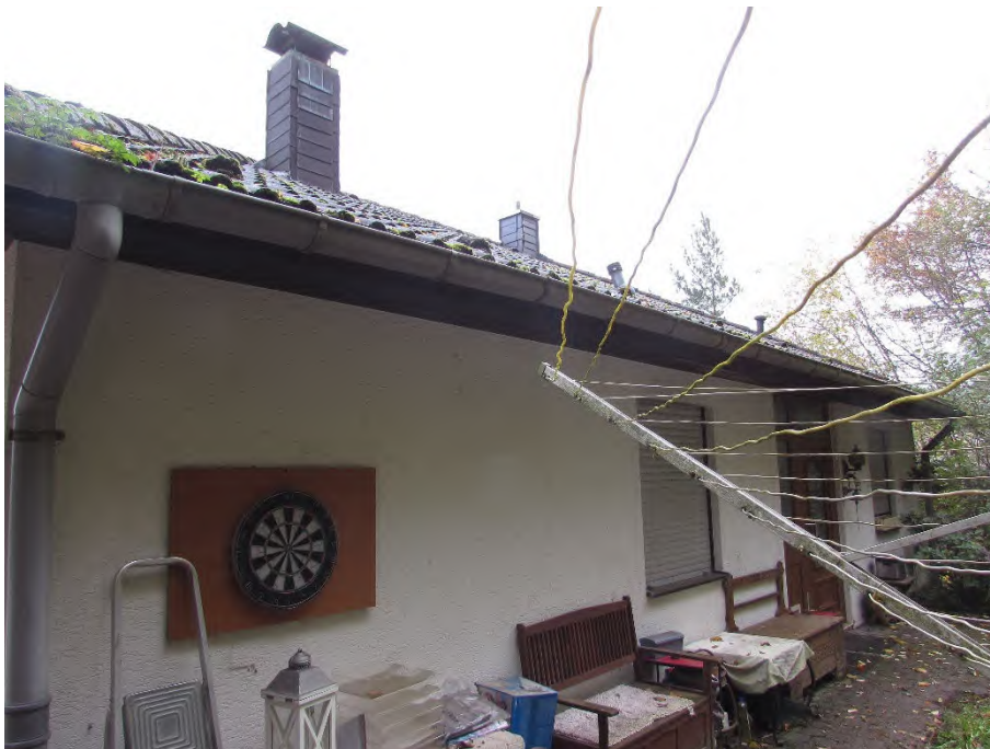
Foto 6: Wohnhaus, Erdgeschoss, rückwärtige Ansicht mit Zugang
