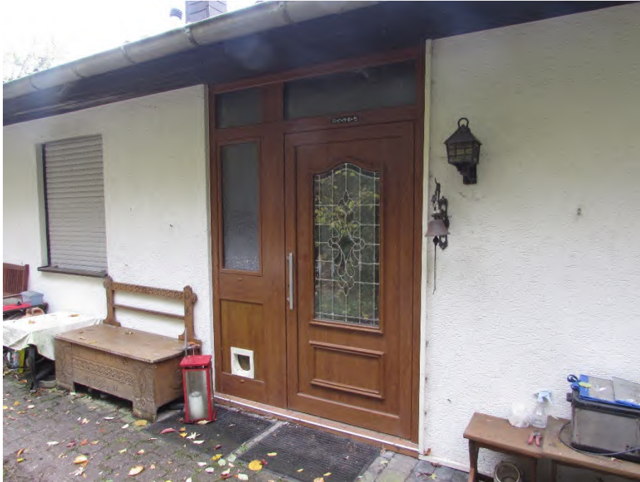
Foto 7: Wohnhaus, Hauseingang zum Erdgeschoss (Hauptwohnung), Türelement mit (ins WC führender) Katzenklappe
