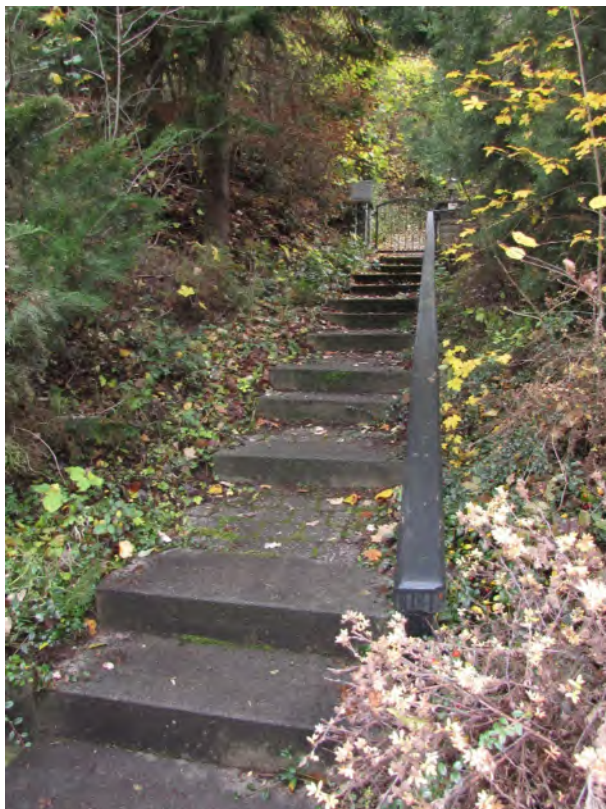
Foto 24: Zugang zum Erdgeschoss
