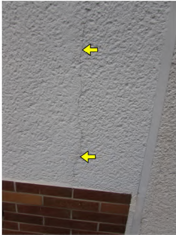
Foto 7: Altbau, Fassade: Putzrisse
