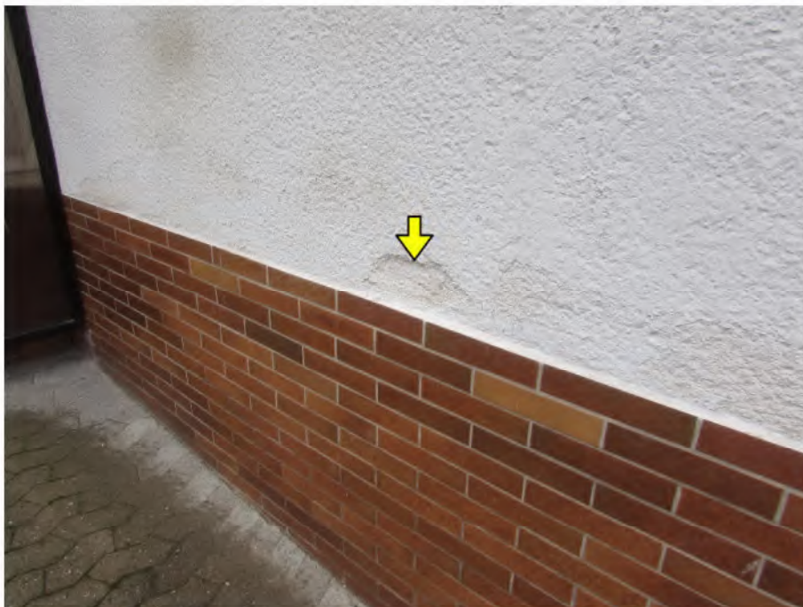
Foto 6: Altbau, Fassade: Putzschäden
