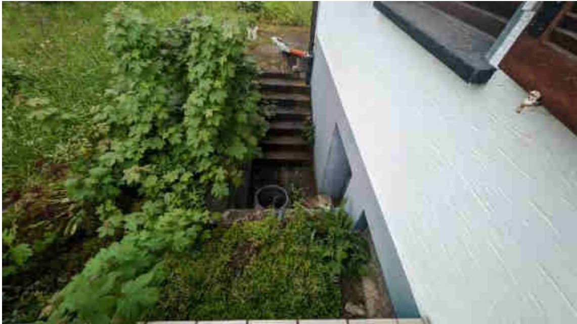
Bild B6 Kelleraußentreppe
