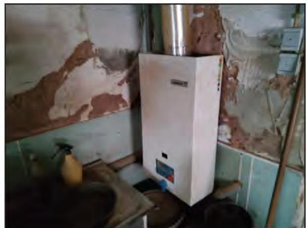
Bild 6: Heizung KG, Feuchtigkeitschäden
