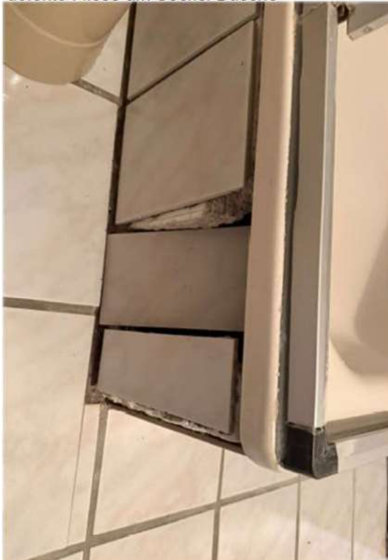
defekte Fliese am Sockel Dusche
