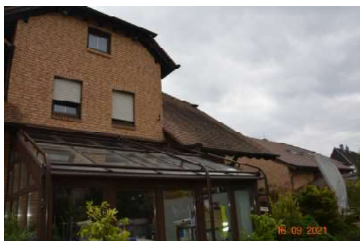
Gebäudeansicht von Westen von der Gartenseite aus betrachtet
