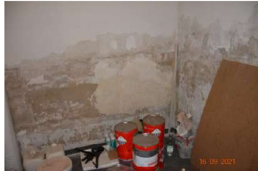
Feuchte Außenwände
