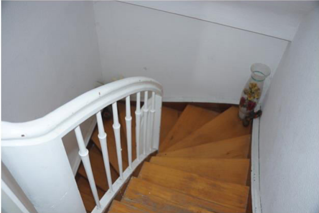
Bild-Nr. 25: Treppe zur Wohnung DG
