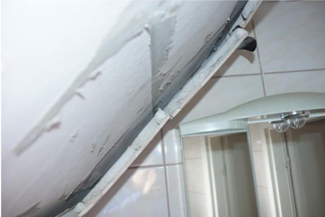
Bild-Nr. 43: abgelöste Fliesenwand
