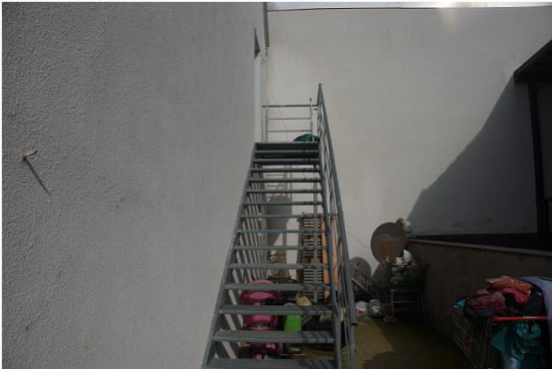
Bild-Nr. 15: Außentreppe ins OG
