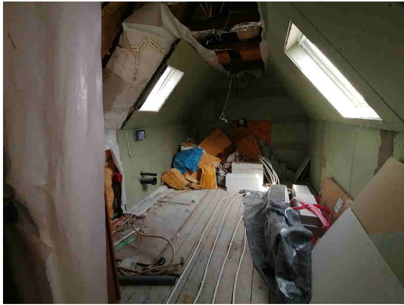
Aufnahme 9: Badezimmer Dachgeschoss (Rohbauzustand)
