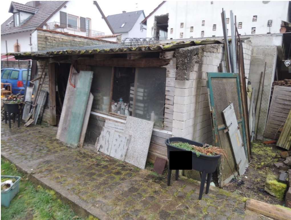
Schuppen II (Dach vermutlich mit asbesthaltigen Wellplatten)
