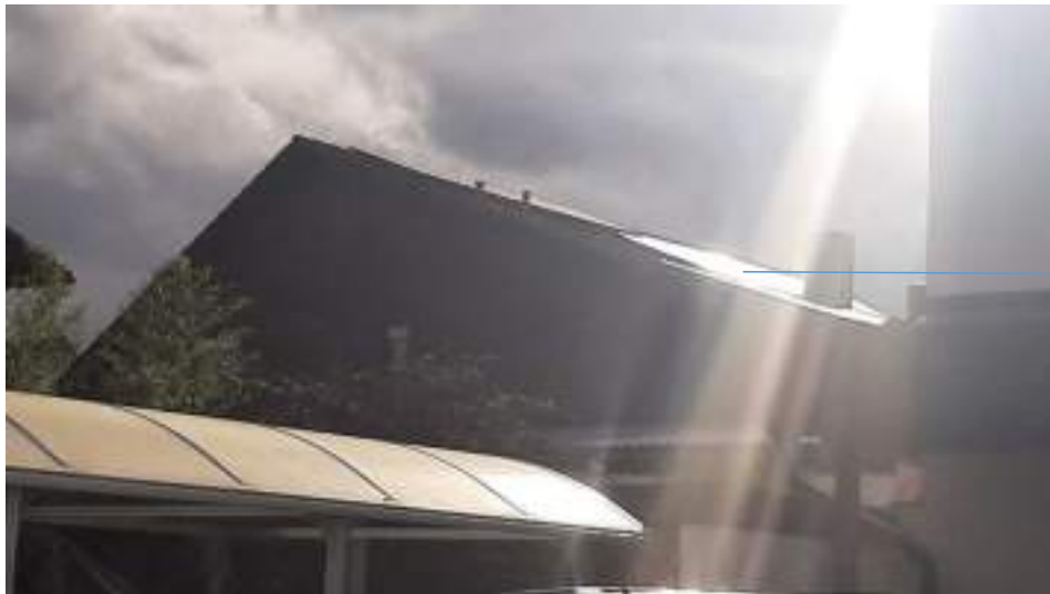
Dachflächenansicht seitens der Heßheimer Straße
