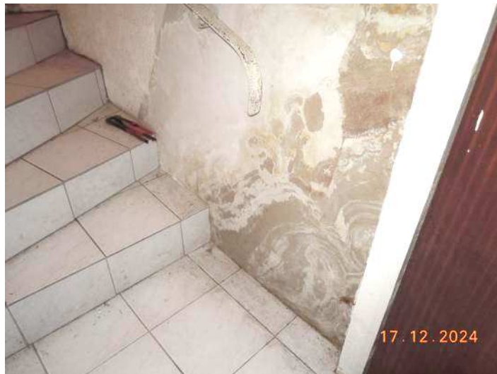
Abb. 12: Feuchtigkeitsschäden im Kellergeschoss des Anbaus
