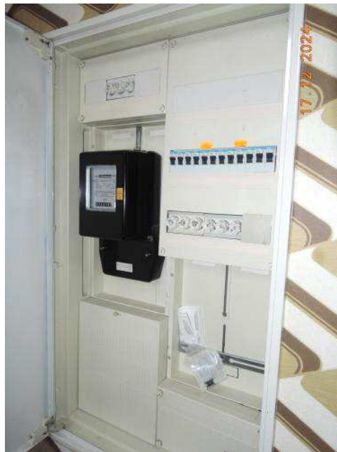
Abb. 5: erneuerter Sicherungskasten
