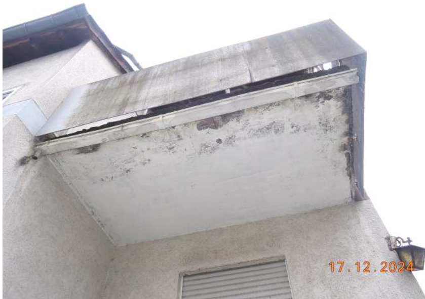
Abb. 26: Feuchtigkeitsschäden am hofseitigen Balkon
