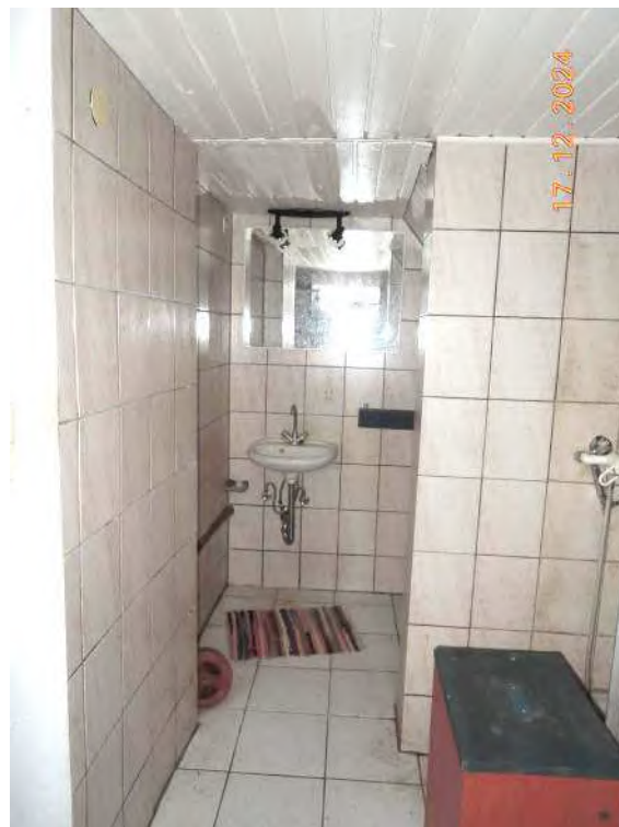
Abb. 14: Dusche im Kellergeschoss des Anbaus
