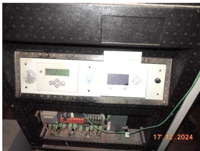
Abb. 18: Heizungstechnik (Steuerung)
