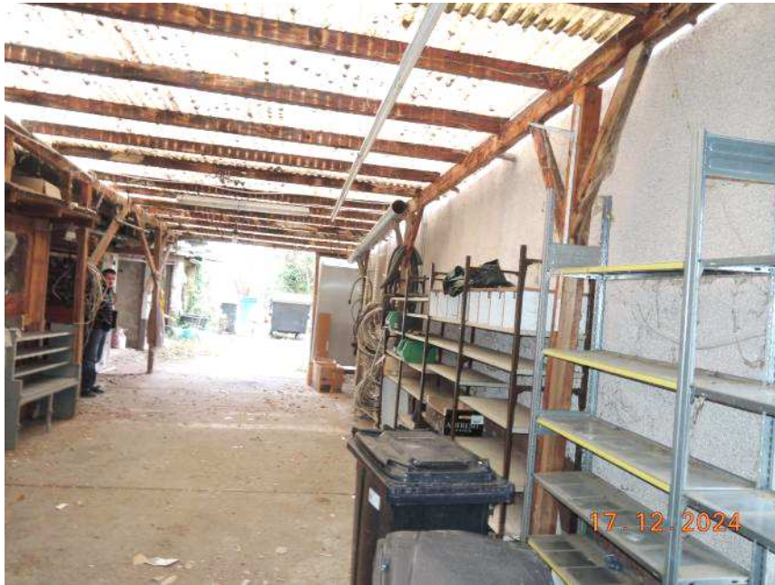
Abb. 23: Innenansicht Hofüberdachung, links und Garagen-/Lagergebäude
