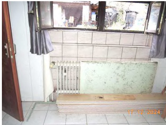
Abb. 13: Raum im Kellergeschoss des Anbaus
