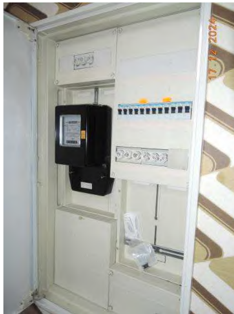
Abb. 5: erneuerter Sicherungskasten
