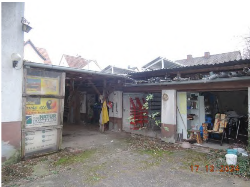
Abb. 24: Hofansicht Garagen-/Lagergebäude, Hofüberdachung
