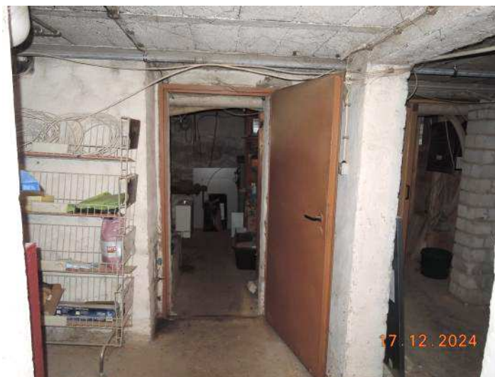
Abb. 16: Keller im Ursprungsgebäude
