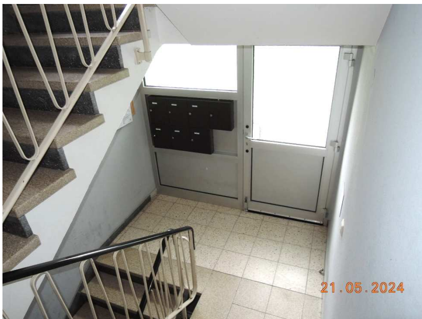
Bild 2: Hauseingang und Treppenhaus
