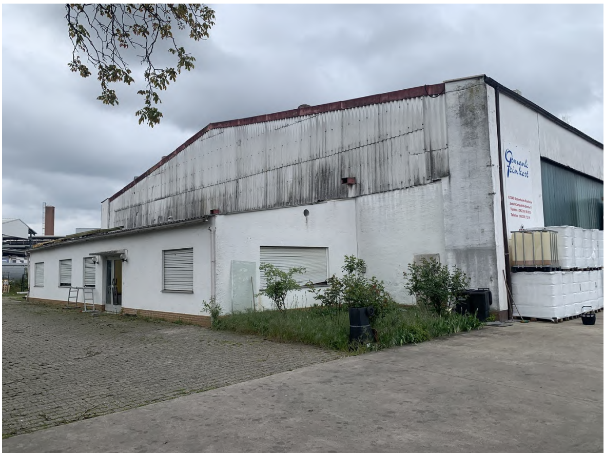
Giebelansicht von Norden
