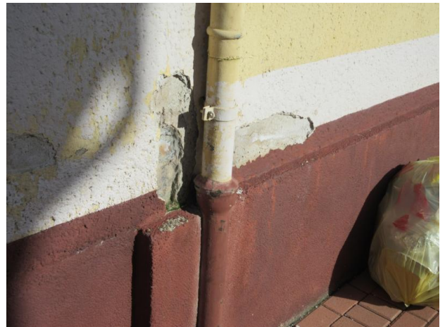
Putzschäden Fassadenbereich
