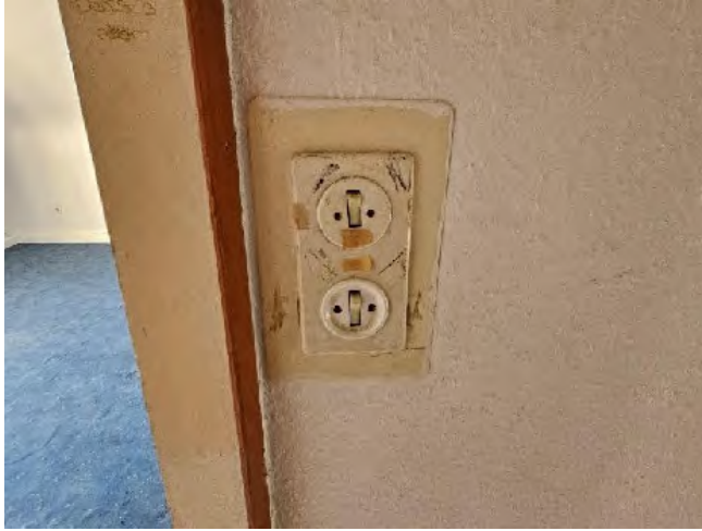
Überalterte E-Installation
