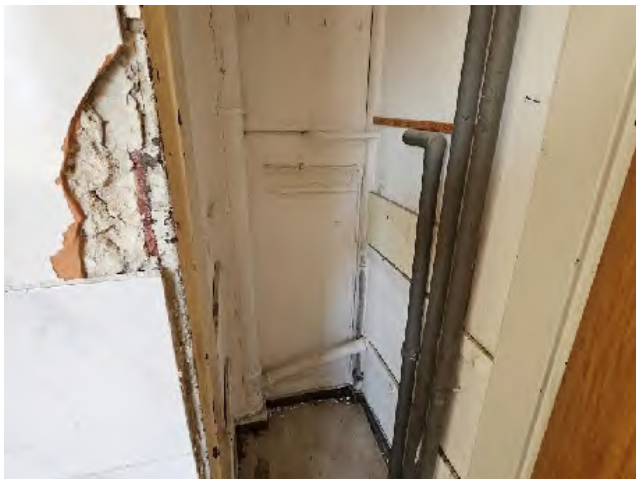
Putzschäden, Installationsraum
