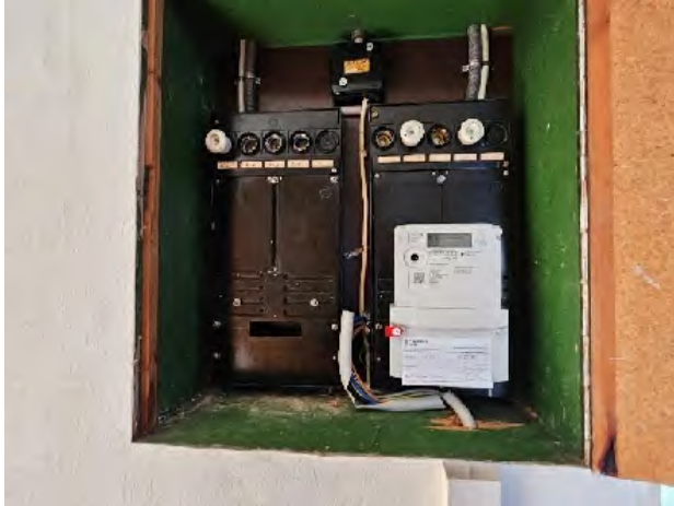
Stromzählerplatz, überaltert
