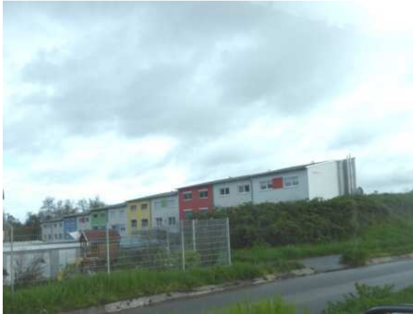
Reihenhausbebauung, Ansicht von Kreisstraße
