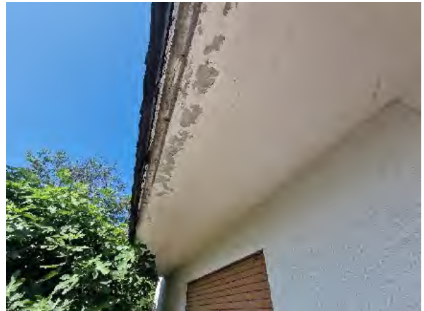
Bild 14 – Putzabplatzung Balkon
