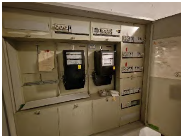
Bild 31 – Zählerschrank
