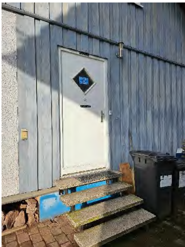
Hauseingang, fehlender Handlauf an Eingangstreppe
