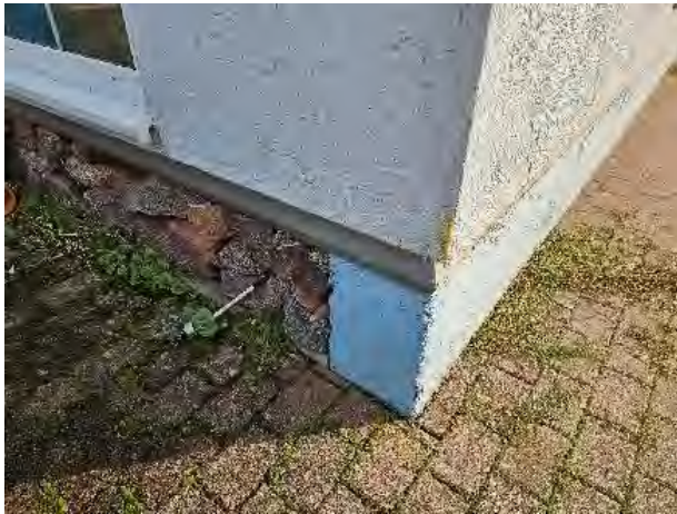
Mängel an Putz und Unterkonstruktion
