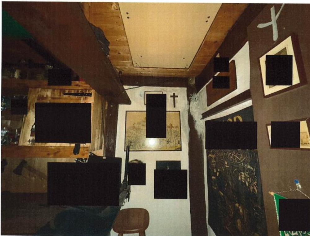
Ausziehtreppe (am Termin beschädigt) für Speicher
