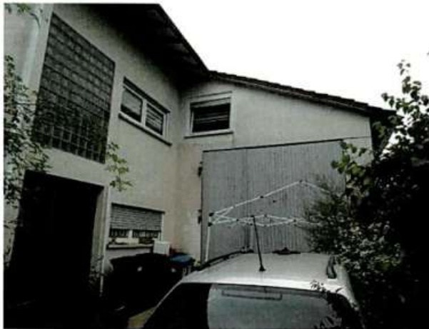
Hauseingang und Zugang zu Kelterhalle
