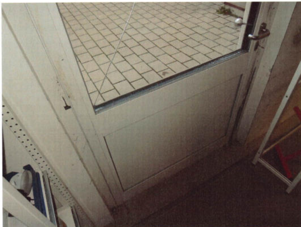
Tür zur geschlossenen Garagenfläche
