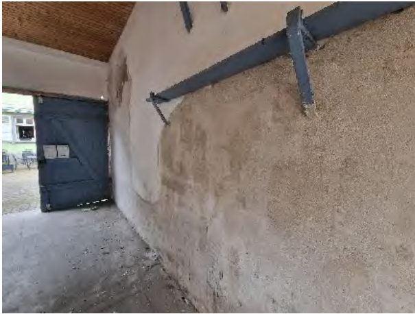
Bild 43 – Putzabplatzungen
