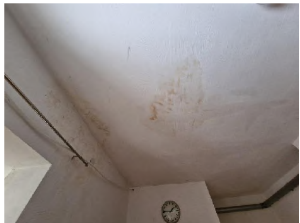
Bild 46 – Wasserschaden OG
