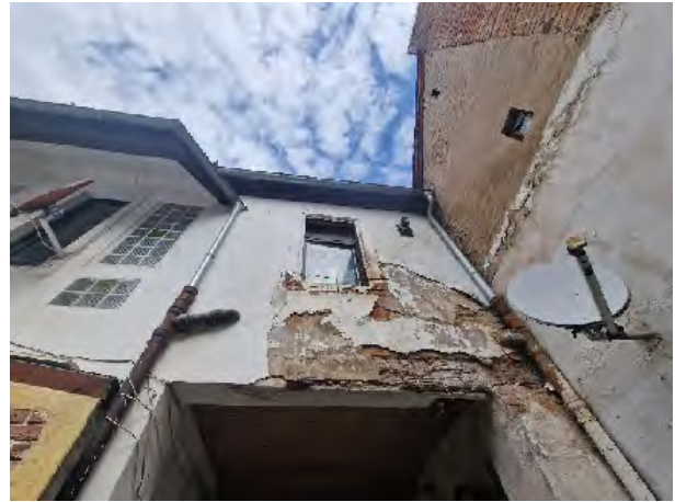
Bild 44 – Massiver Feuchtigkeitsschaden
