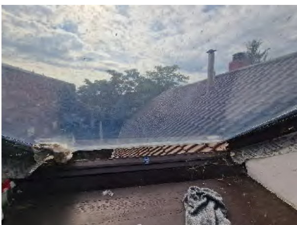
Bild 53 – Defektes Dachflächenfenster
