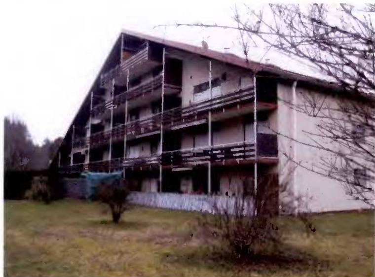
Blick vom Garten auf die Vorderseite (Hauseingangsbereich) des Gebäudes
