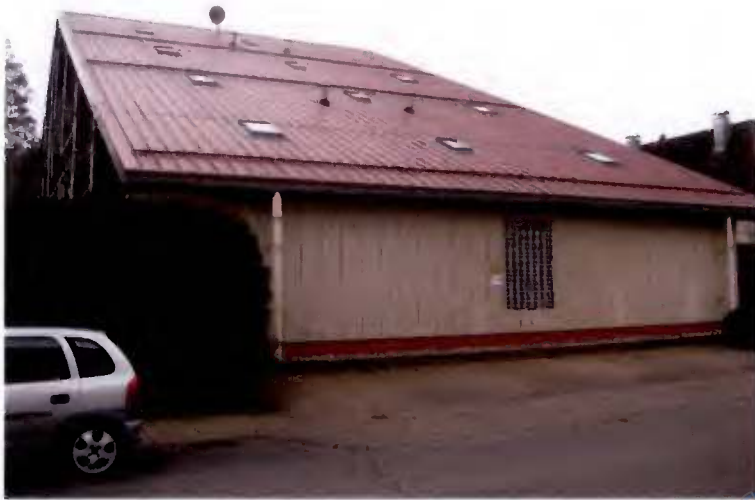
Blick von der Lindenstraße auf das Dach des Gebäudes
