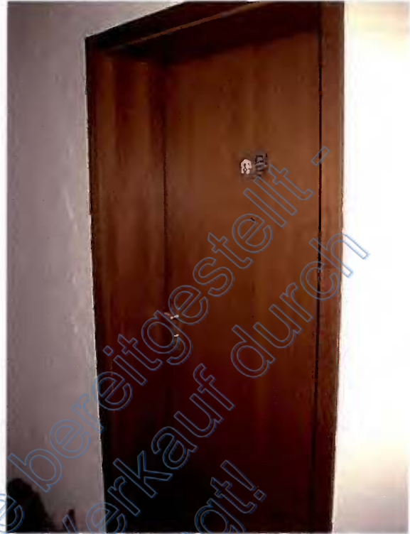
Blick auf die Wohnungseingangstür Sondereigentum Wohnung 1 im EG
