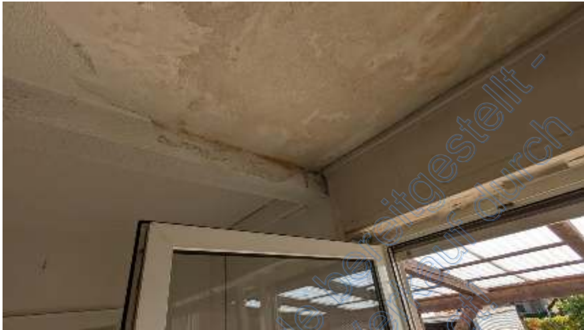
Bild 13: Wasserschaden am Unterzug im Wohnzimmer
