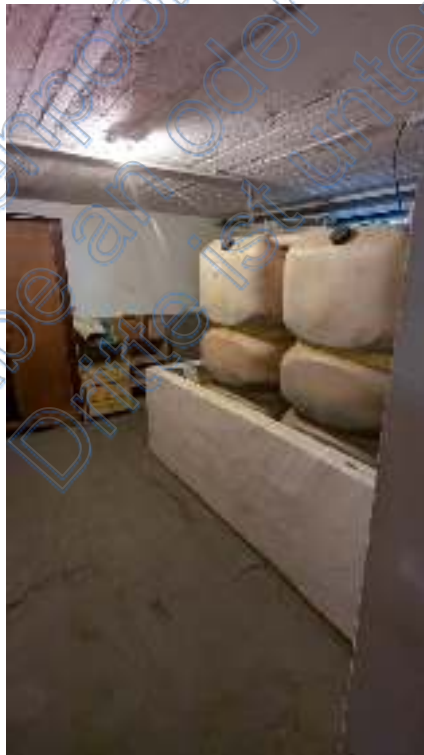
Bild 22: Heizungsraum mit Kunststofftanks
