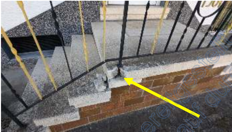
Bild 7: Eingangspodest mit ausgebrochenem Belag
