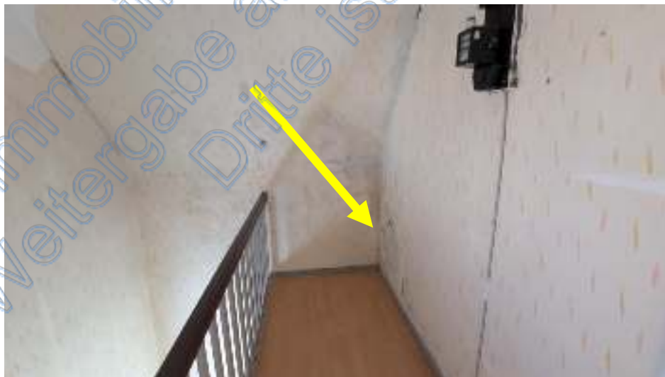
Bild 20: Feuchtschäden an der Trennwand Flur-Duschbad nach Wasserschaden im Bad
