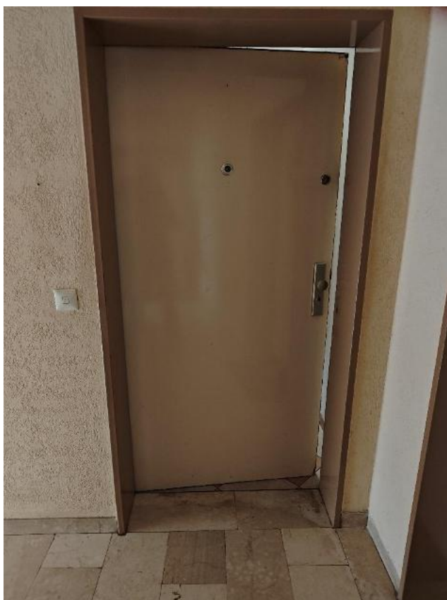
Eingang zu Wohnung 4
