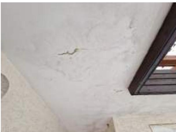
Bild 35 – Feuchteschaden Garage
