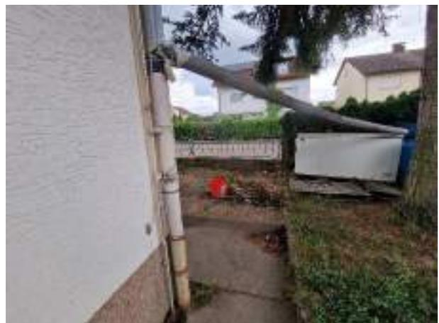
Bild 10 – Provisorisches Fallrohr
