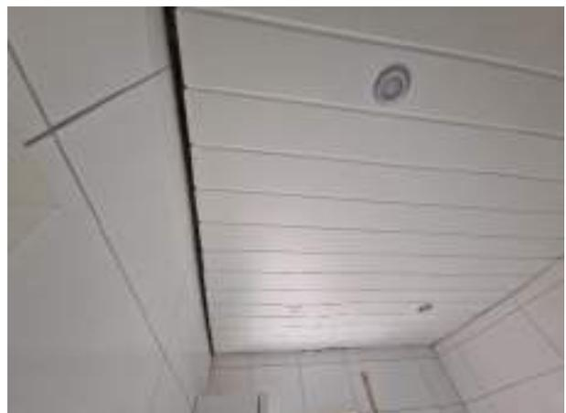
Bild 18 – abgehängte Holzdecke
