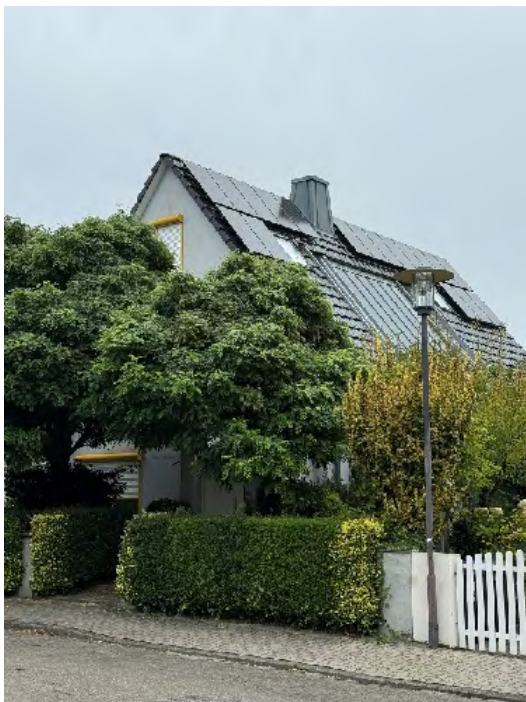
Ansicht Dach / PV-Anlage
