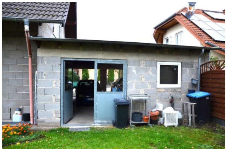
Gartenansicht Garage von Südosten
