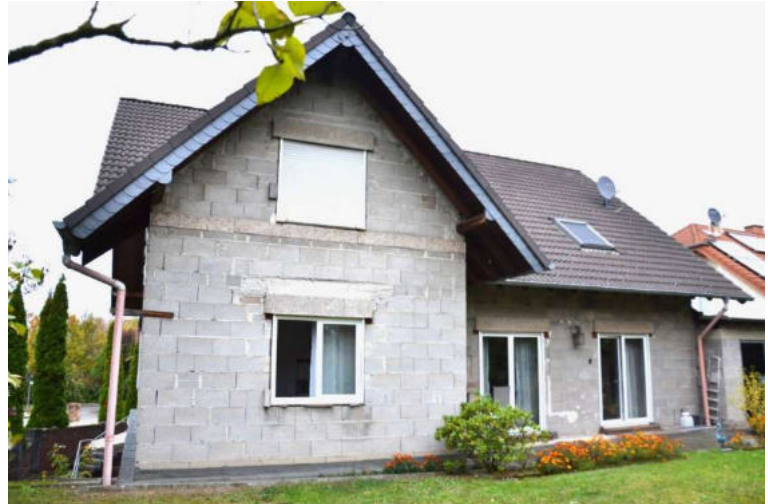
Gartenansicht Wohnhaus von Süden
