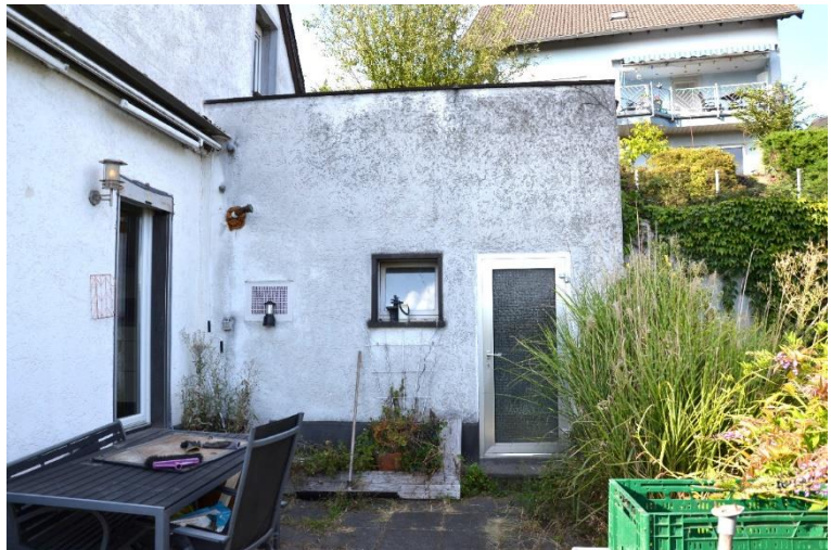
Anbau an die östliche Giebelwand
