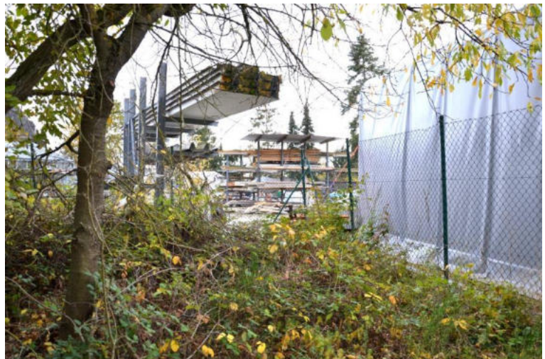
Blick auf die südwestliche Grundstücksecke
