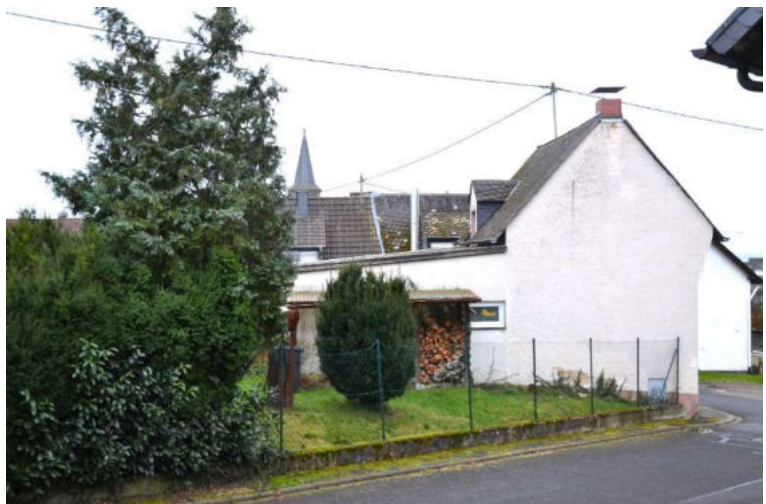
Ansicht von Nordwesten (Bergstraße)
