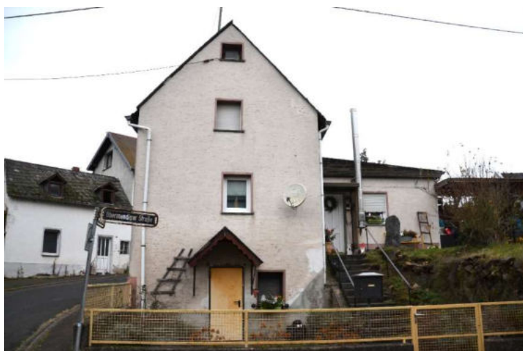
Straßenansicht von Südosten (Obermendiger Straße)
