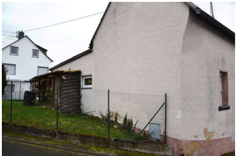
Nordwestseite des Wohnhauses
