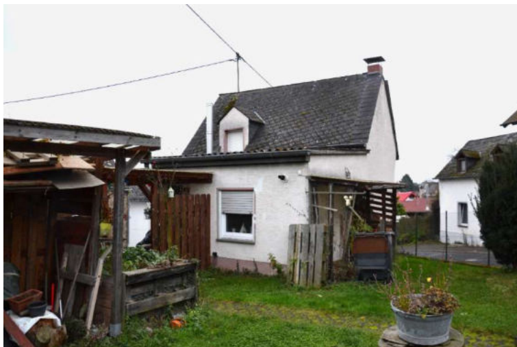
Nordansicht Wohnhaus (Blick vom Carport)
