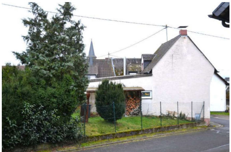
Ansicht von Nordwesten (Bergstraße)
