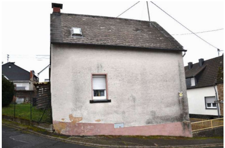
Ansicht von Südwesten (Bergstraße)
