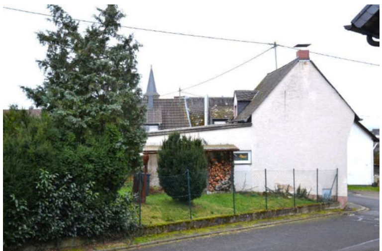
Ansicht von Nordwesten (Bergstraße)
