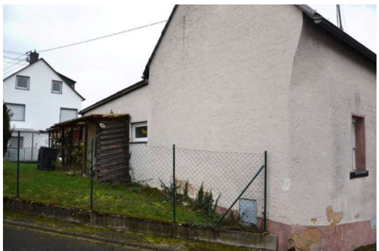
Nordwestseite des Wohnhauses
