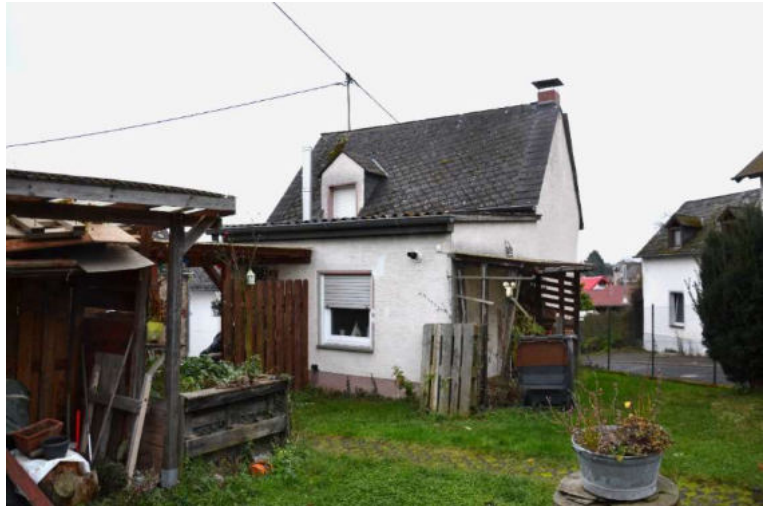
Nordansicht Wohnhaus (Blick vom Carport)
