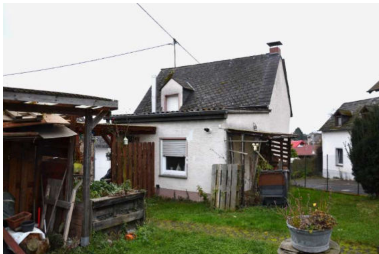
Nordansicht Wohnhaus (Blick vom Carport)
