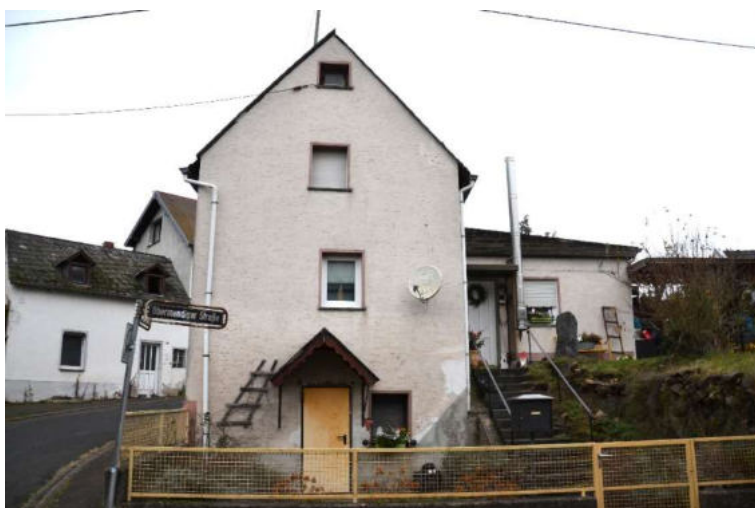
Straßenansicht von Südosten (Obermendiger Straße)
