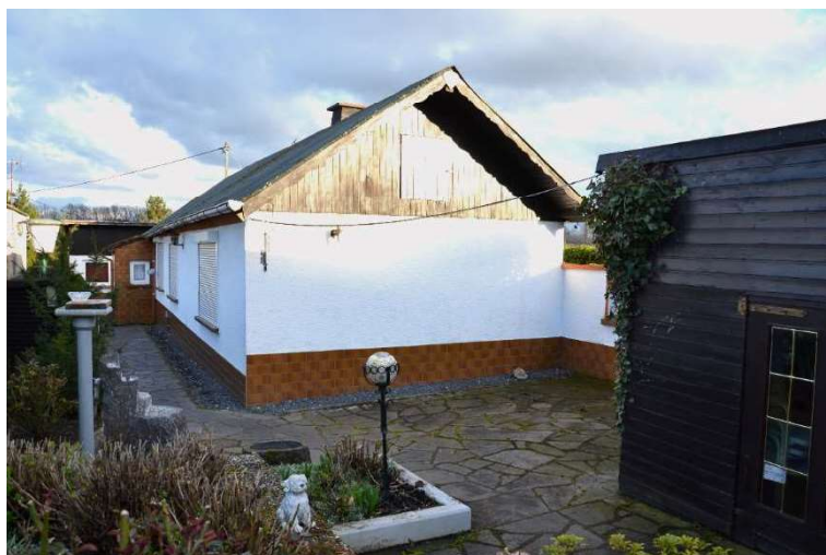
Wohnhaus Ansicht von Westen
