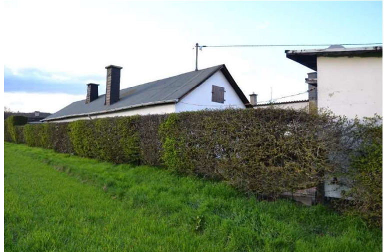
Wohnhaus Ansicht von Südosten
