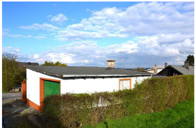
Garagengebäude Ansicht von Südwesten
