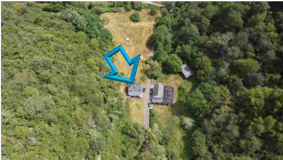
Bild B5 exemplarische Gebäudeansicht
