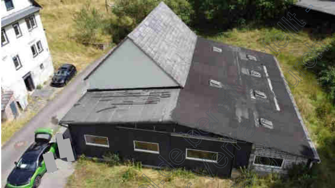
Bild B1 exemplarische Gebäudeansicht
