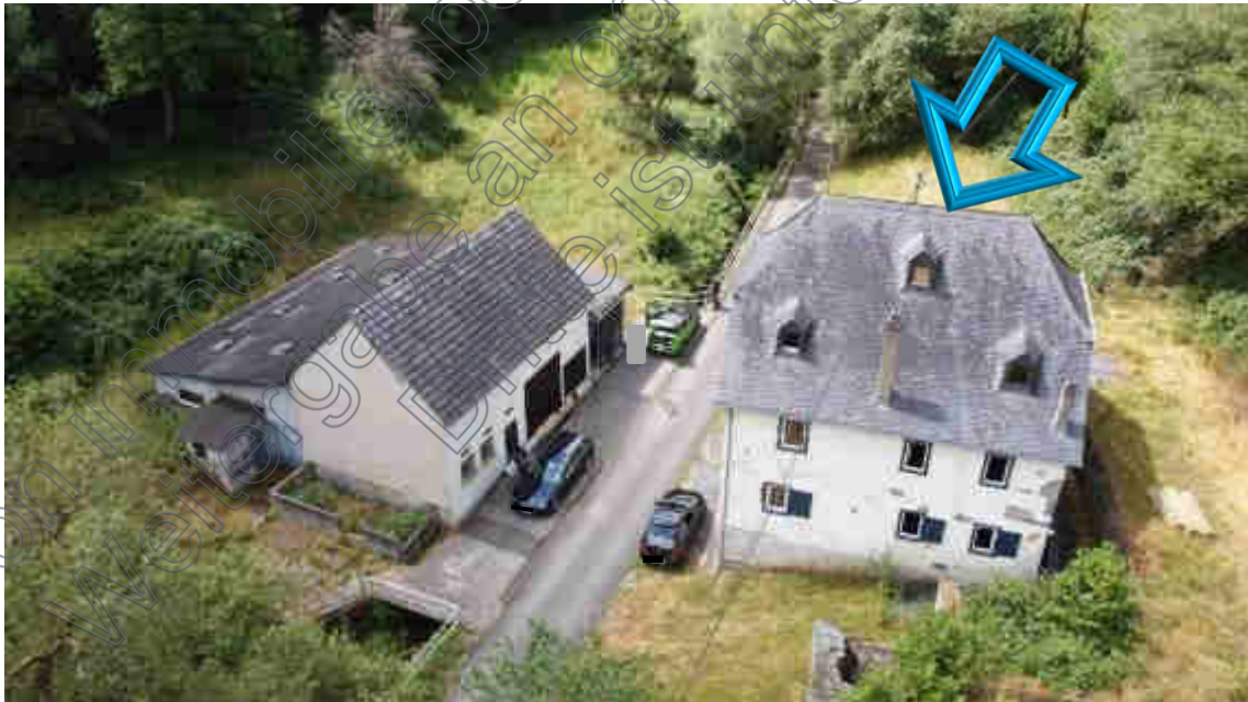
Bild B4 exemplarische Gebäudeansicht
