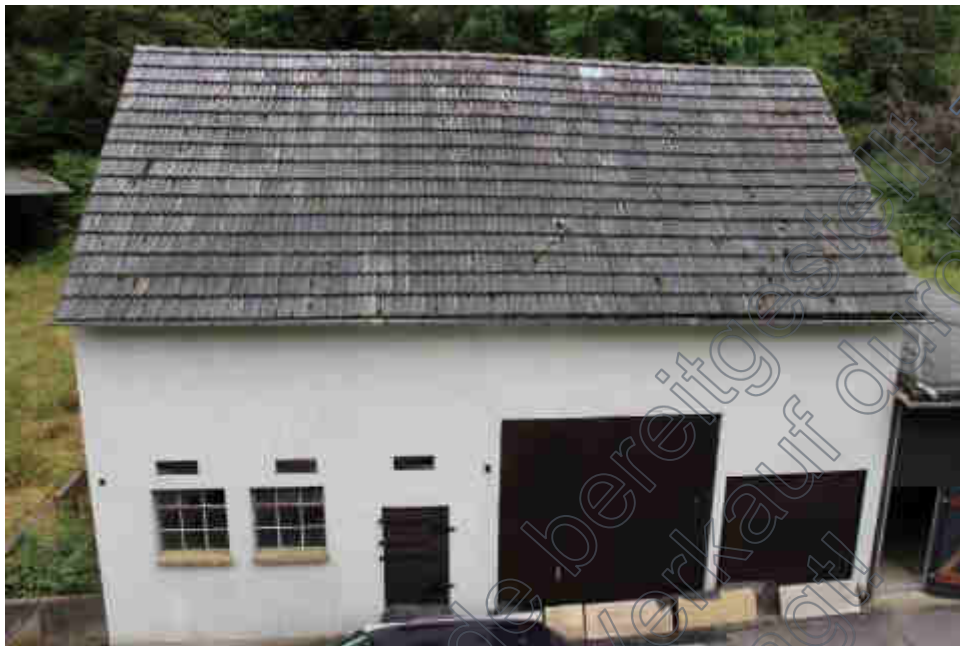
Bild B5 exemplarische Gebäudeansicht
