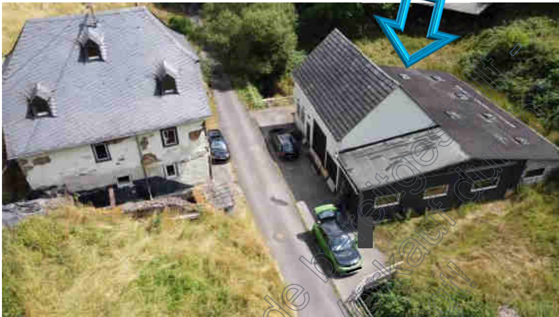
Bild B3 exemplarische Gebäudeansicht
