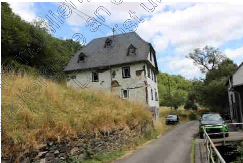
Bild B2 exemplarische Gebäudeansicht
