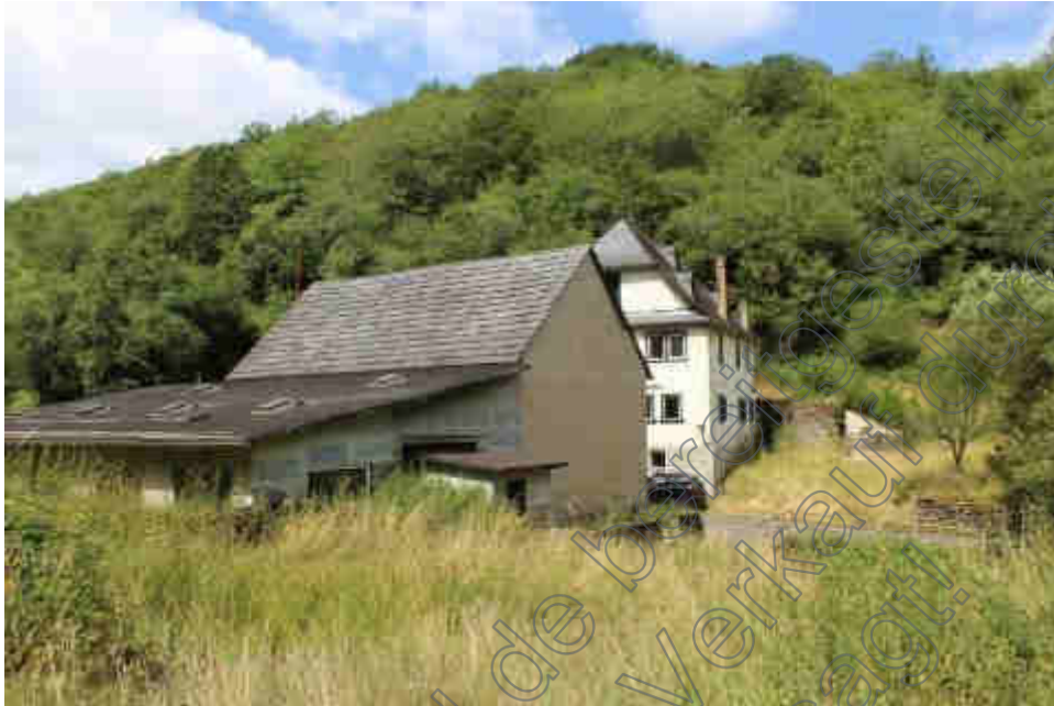
Bild B7 exemplarische Gebäudeansicht
