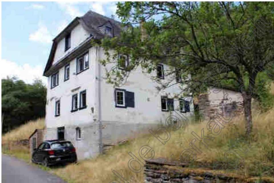
Bild B1 exemplarische Gebäudeansicht
