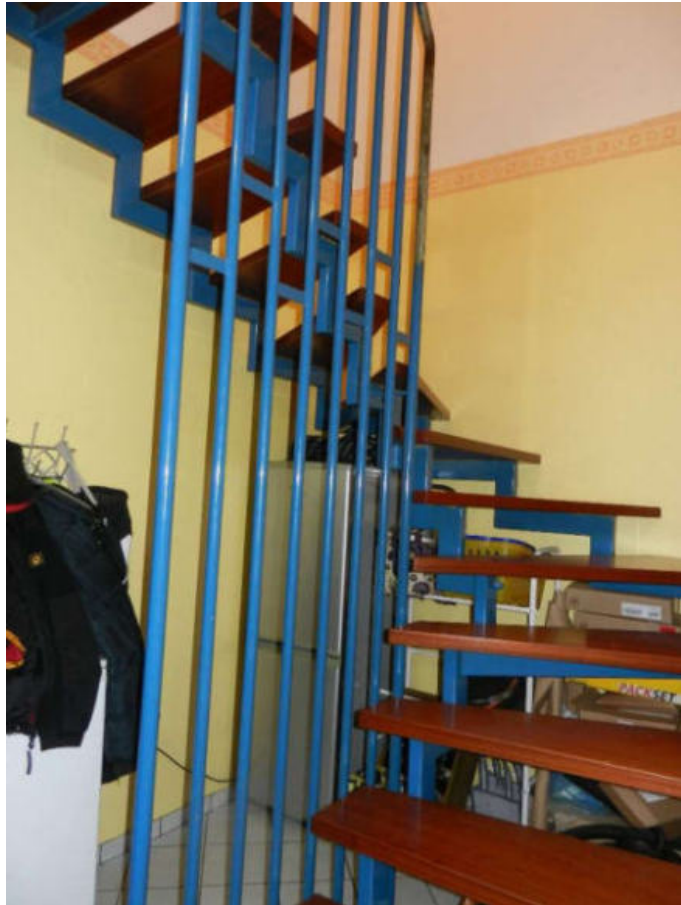
Bild 12: Stahltreppe mit Holzstufen vom EG zum DG
