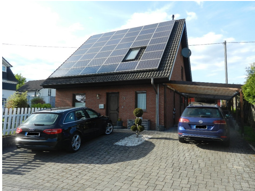
Bild 1: Ansicht von der „Hacksener Straße“
