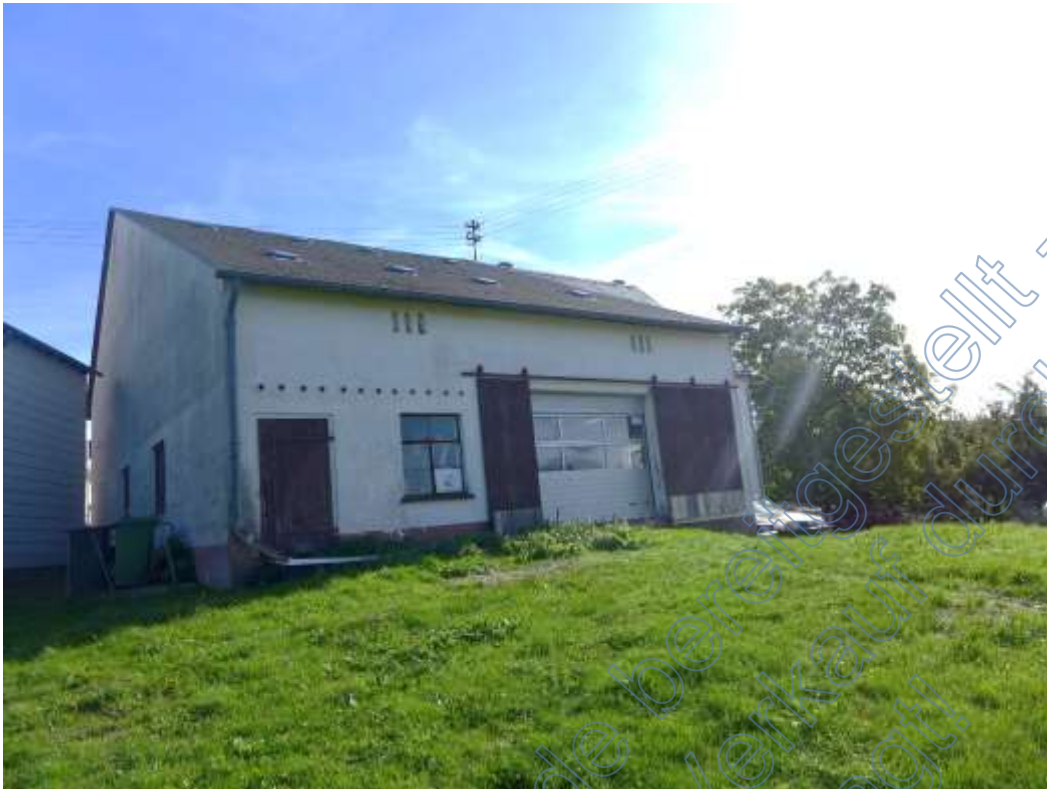
11 Rückansicht Scheune, Freifläche
