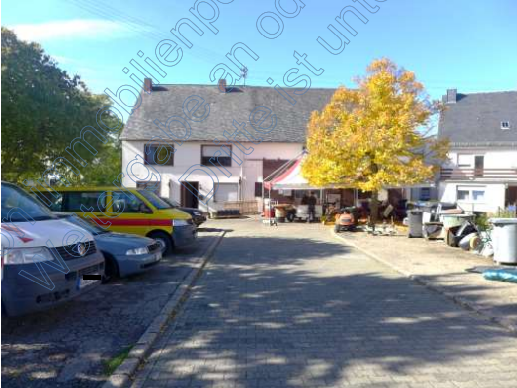
2 Zugang, Ansicht von der Straße, links Flurstück 115/1 (genutzt als Stellplatzfläche)
