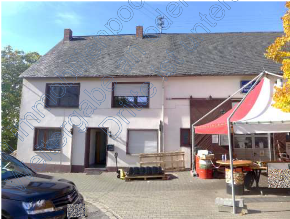
6 Frontansicht Wohnhaus (links) mit angebauter Scheune (rechts)
